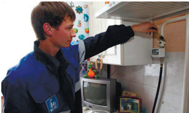
Законодательная обязанность устанавливать газоуловители, газосигнализаторы и т.п. отсутствует
